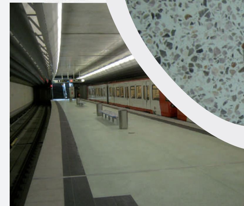
Stadt Nürnberg, U-Bahn am U-Bahnhof, Kaulbachplatz Architekten Haid und Pamter, Nürnberg
